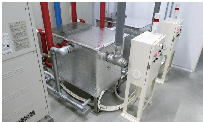
原料の保温に使用する温水槽および、配管の保温性能を見直しました。放熱の抑制による熱エネルギーロスの削減および、燃料の使用量を削減しました。
