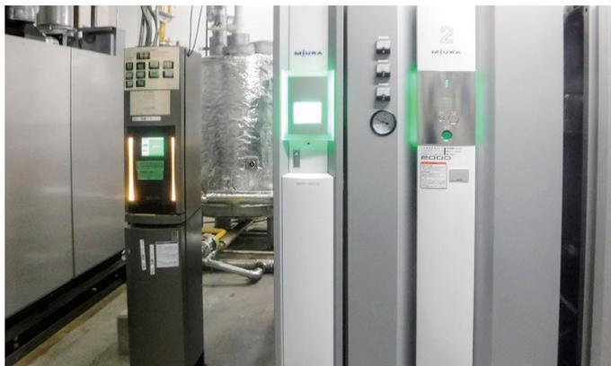
既存のボイラー設備を、従来の石油燃料から都市ガスを燃料とする燃焼効率を向上したものに更新しました。石油資源の使用量の削減と省エネルギーを図りました。
