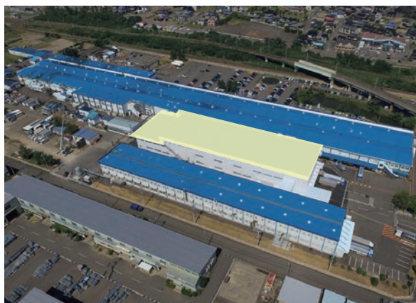
② 上越工場 新潟県上越市
