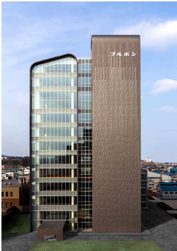
株式会社ブルボン 本社ビル
